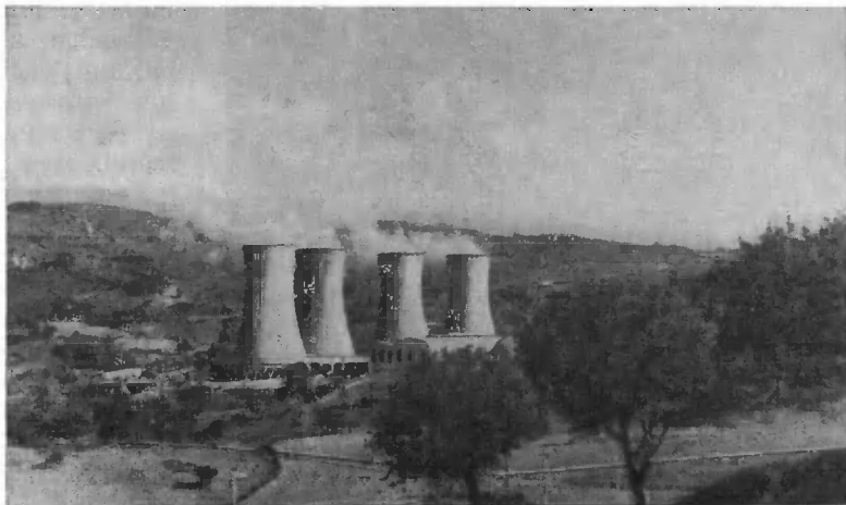
Лардерелло. [Геотермическая электростанция]
